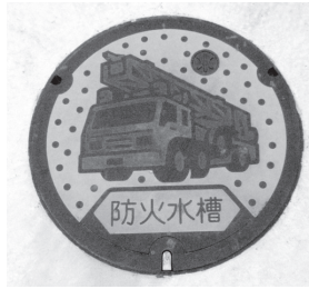
防火水槽の表示
