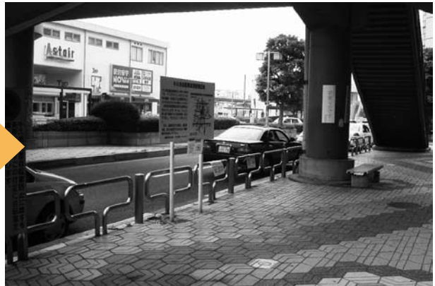
牛久駅西口（撤去実施後）
