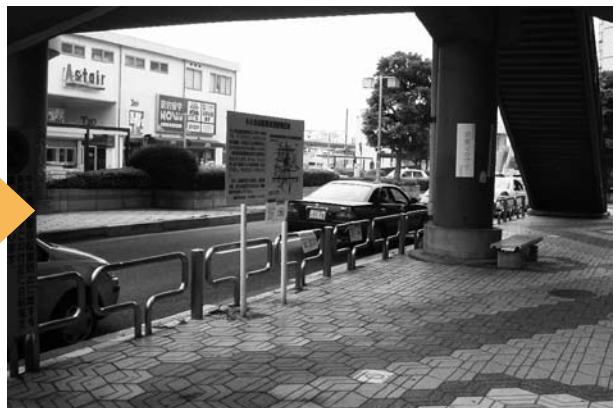
牛久駅西口（撤去実施後）
