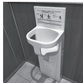
個室トイレやバリアフ リートイレ内で乳幼児を 安全に待たせることが できるベビーキープ
