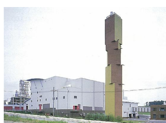
牛久クリーンセンター（焼却施設）
