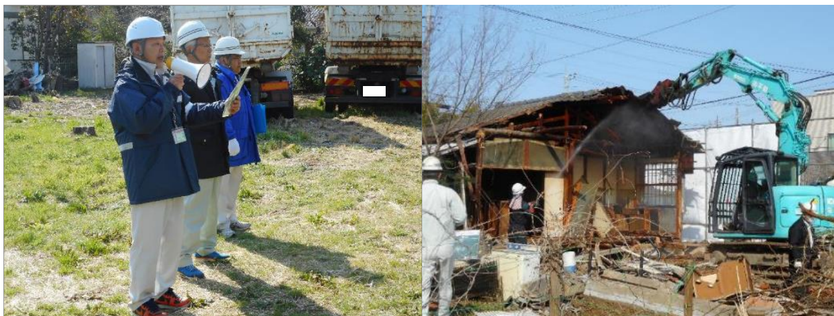
略式代執行による特定空家等の解体
