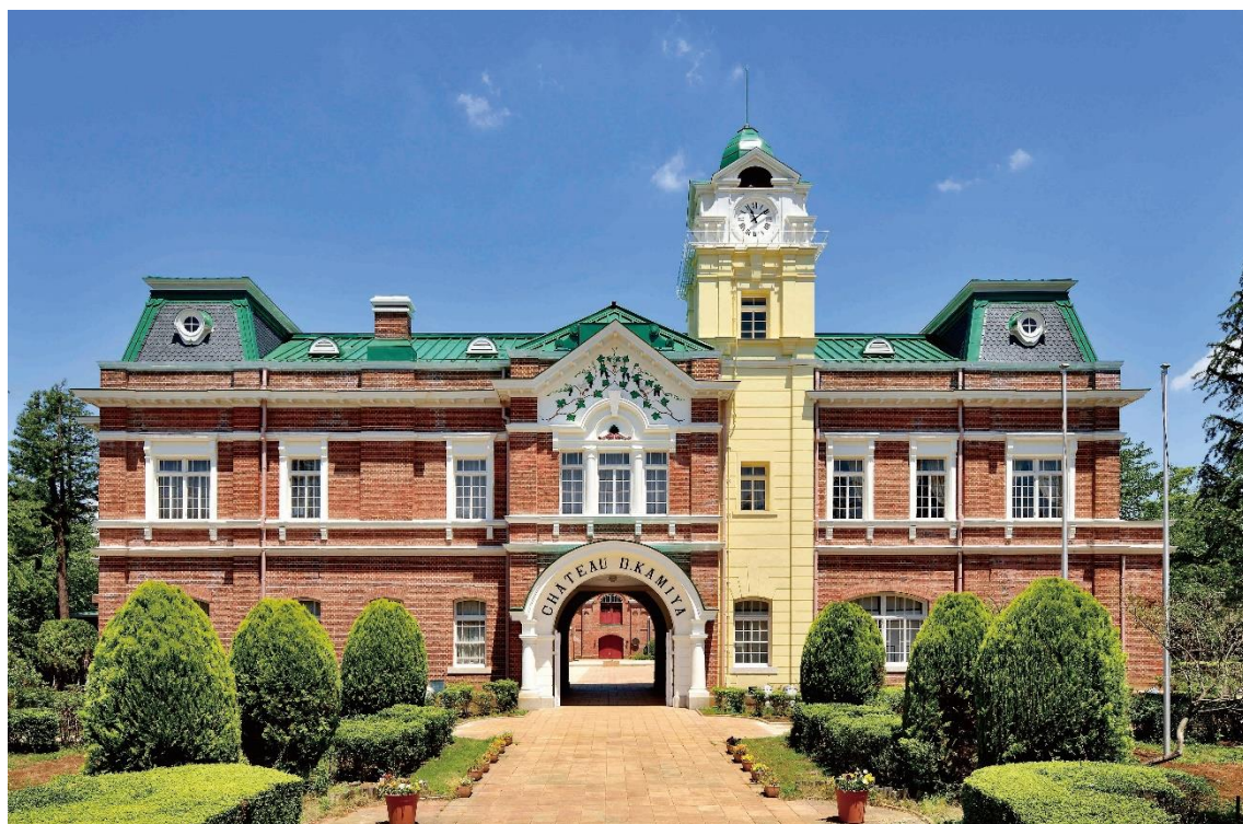
牛久シャトー本館（国重文シャトーカミヤ旧醸造場施設事務室）
