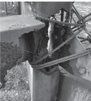
腐食が進んだ野球用バックネットの支柱。早期の修繕が待たれる。
