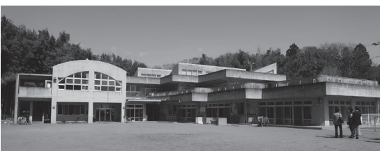
今年度長寿命化工事を行う下根保育園
