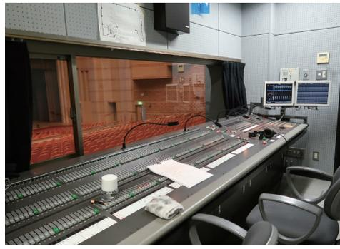
平成14年に更新して以降22年使用。昨年からの起動不良等が発生している。調査の結果は経年劣化による動作不良。部品供給の終了などにより修理困難なため更新を行う。
