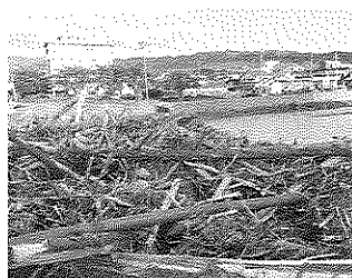
令和6年能登半島大雨災害(輪島市)
