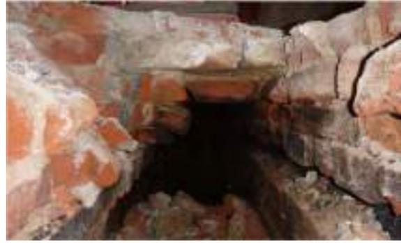
写 1-17 煙道内部 煉瓦積内部は中道となって内面には煤が付着しているため煙道とわかる
