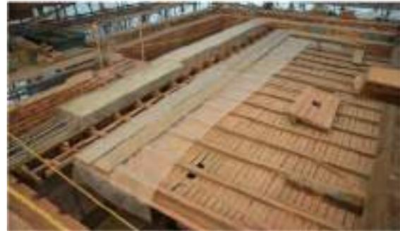
鉄筋コンクリート製臥梁設置状況
