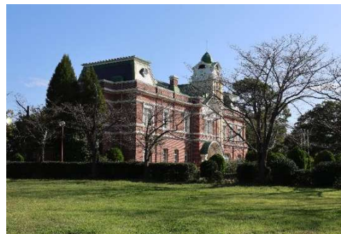
重要文化財（建造物）事務室全景
