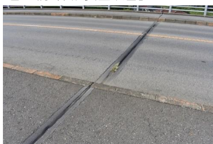
【刈谷大橋 伸縮装置取替】
