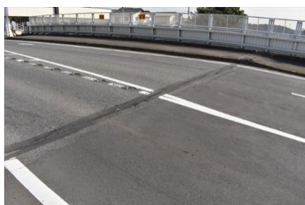
【北浦跨線橋 伸縮装置取替、舗装打替】
