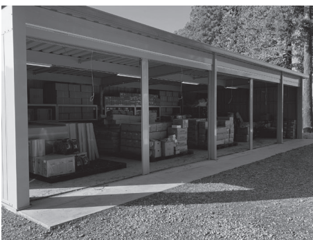
武道館協の防災倉庫
