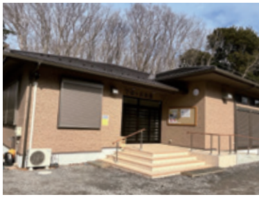
下根ヶ丘行政区区民会館（令和5年度新築）
