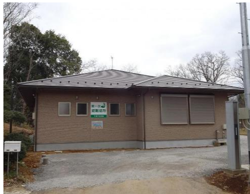
写真：下根ヶ丘行政区区民会館（令和5年度新築）
