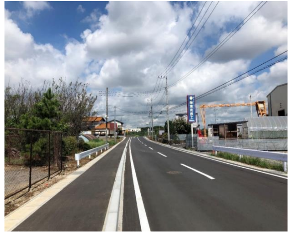
写真：市道52号線（整備済み箇所）
