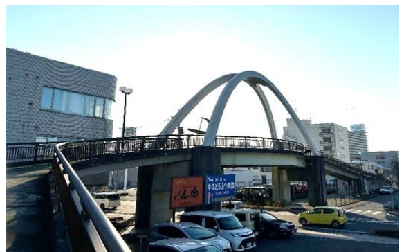
写真：駅東歩道橋(令和6年度予定箇所)
