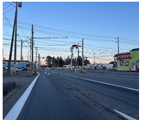
写真：市道2990号線(令和6年度予定箇所)
