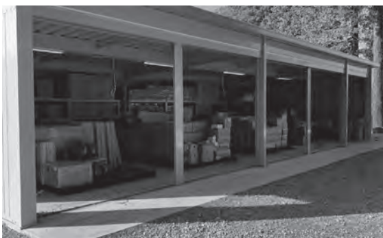
武道館脇の防災倉庫
