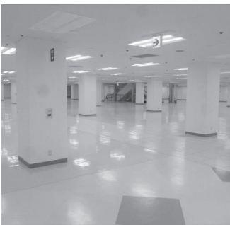
空き床解消できないエスカード牛久ビルの3階
