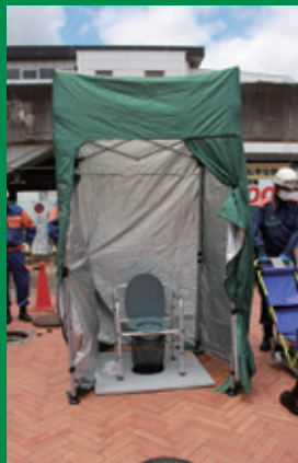
マンホールトイレ
