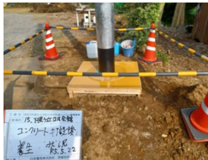
基礎部の打設
