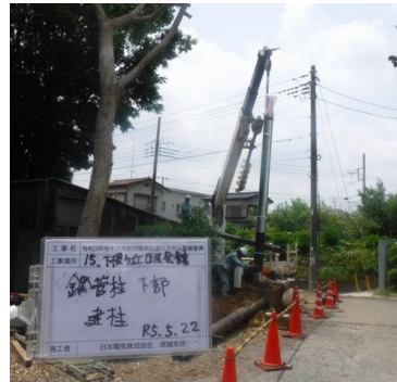
支柱底部の設置
