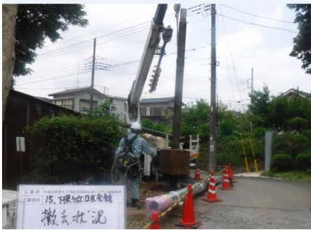
既設支柱の撤去
