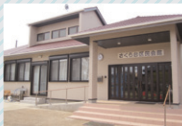
さくら台区民会館 (令和3年度バリアフリー化工事実施)
