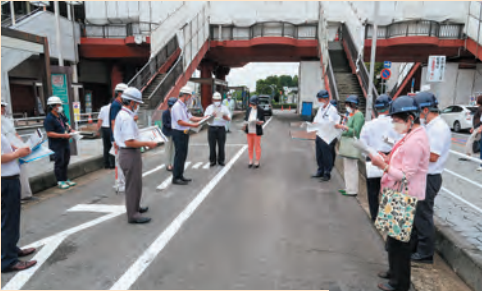
牛久駅西口駅前広場改修工事
