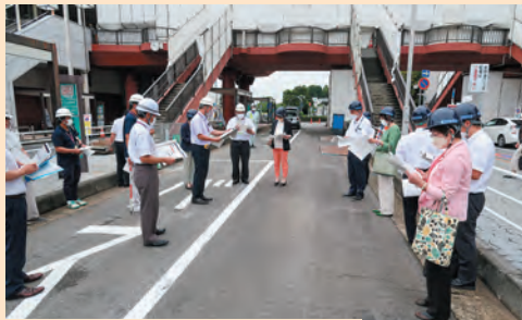
牛久駅西口駅前広場改修工事
