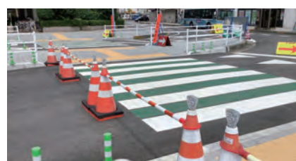
バリアフリー化工事が進む牛久駅西口
