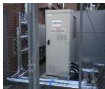
BDF燃料を利用する発電機 (市総合福祉センター)
