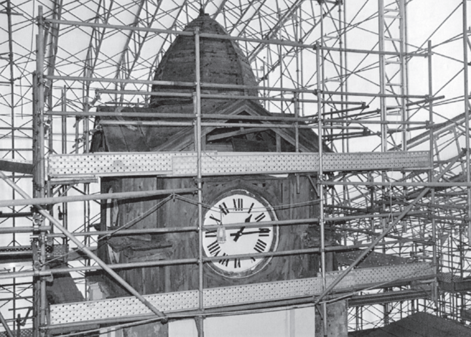
解体修理中の旧事務室(本館)時計塔部分
