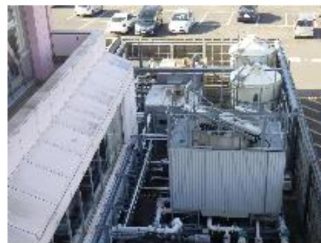
図 1.2.6 市庁舎に設置したペレット焚き冷温水機
