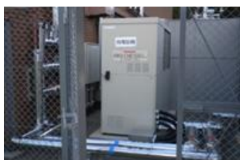
バイオディーゼル燃料を使用する 発電システム(福祉センター)
