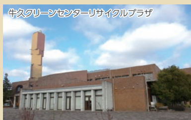
牛久クリーンセンターリサイクルプラザ
