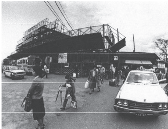
▲【写真2】昭和58年工事中の牛久駅舎
