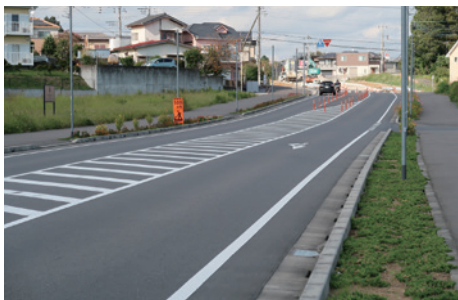
整備が進む市道23号線
