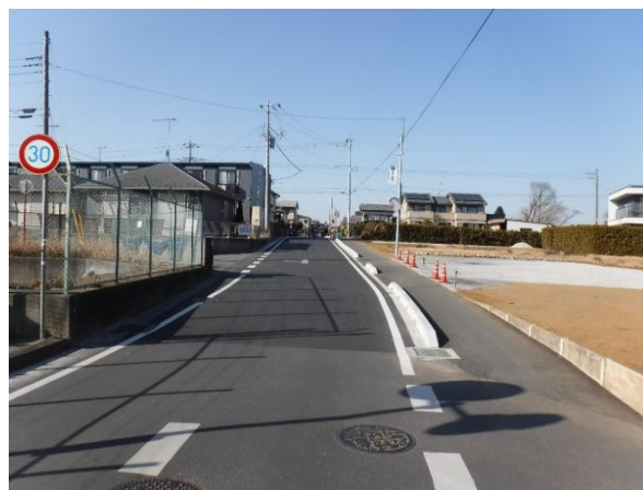
写真: 市道1013号線(整備済み箇所)
