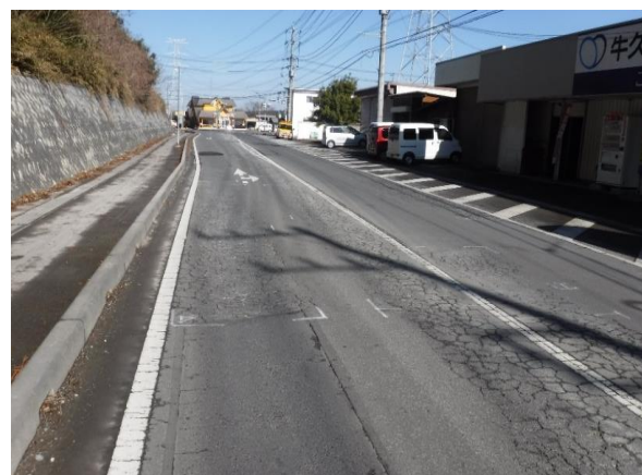
写真：市道8号線(令和3年度予定箇所)
