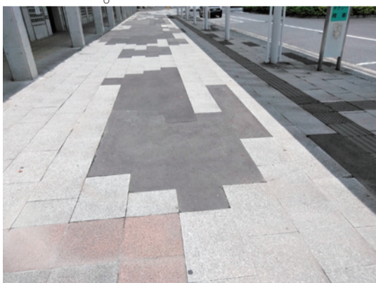
ひたち野うしく駅東口駅前広場のタイル補修箇所
