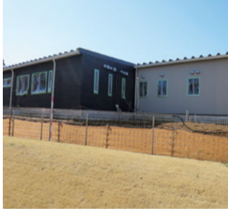
障害者地域活動センター 新築
