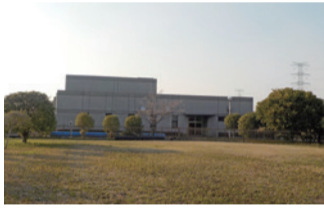
岡見第一汚水ポンプ場
