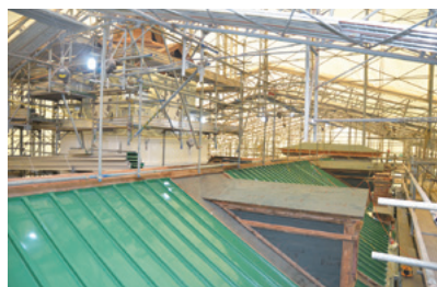
旧事務室修理状況
