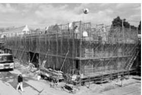
体育館の内部(上)と建て替え中の体育館(下)
