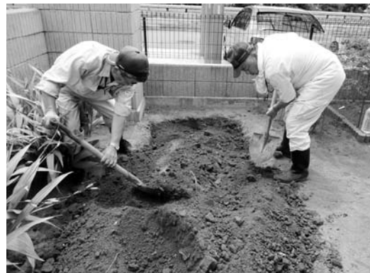
除去土壌の埋設作業
