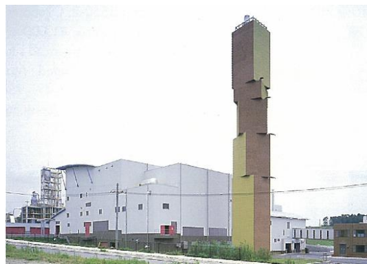
牛久クリーンセンター (焼却施設)
