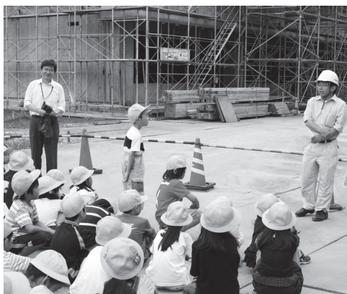
建設中の校舎前で質問をする児童
