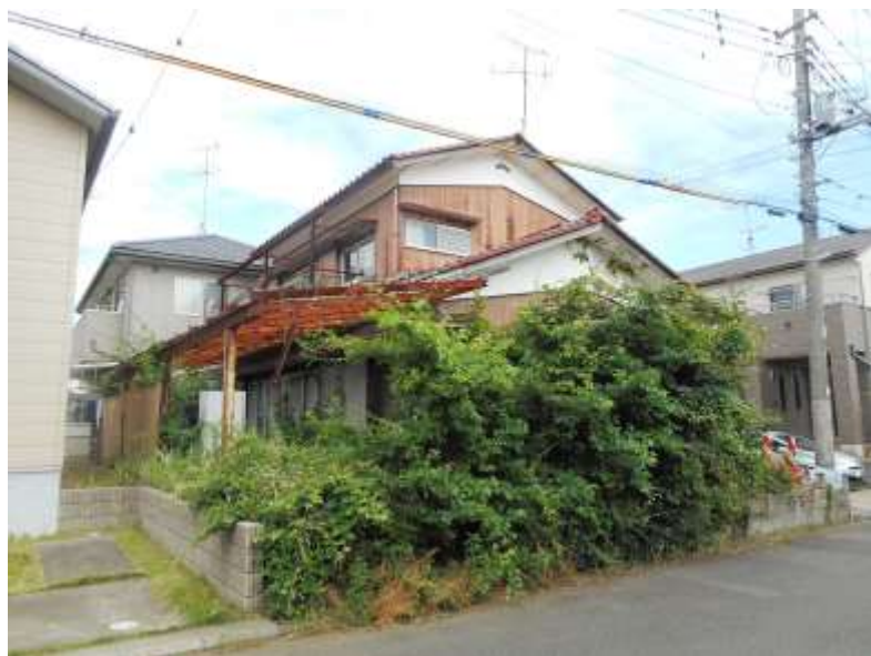
解体前(左) 解体後(右)
