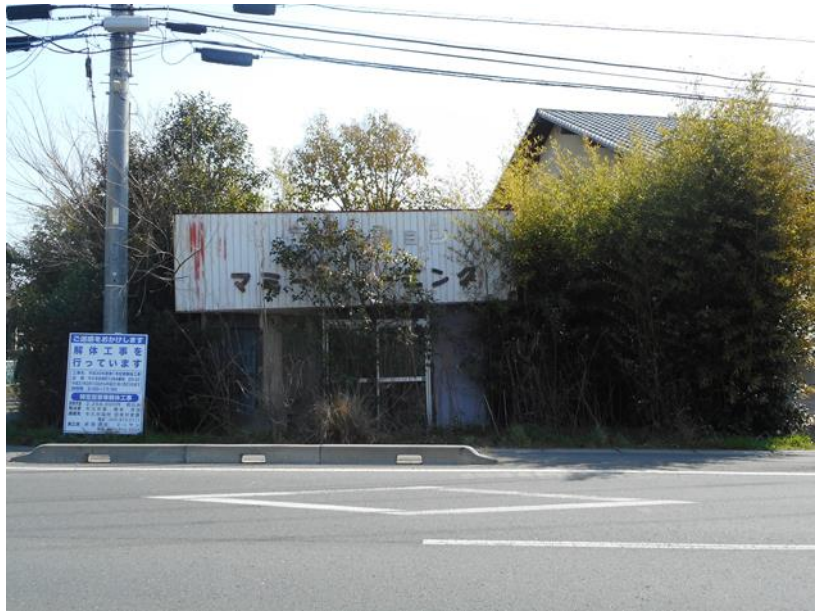
解体前・着工時
