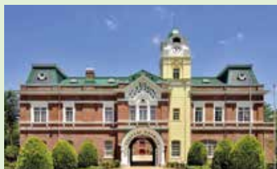
国指定重要文化財：牛久シャトー旧醸造場施設 旧事務室
