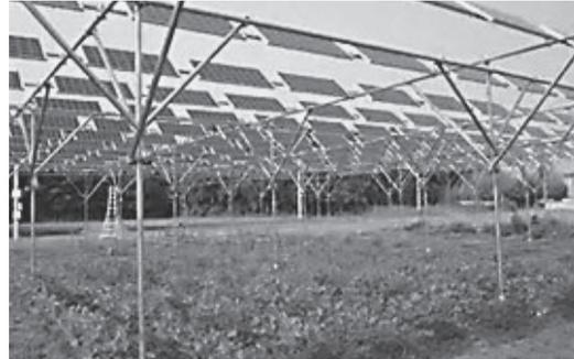
営農型太陽光発電。作物に合わせてパネルの間隔を取り、適度な遮光率を実現している。
