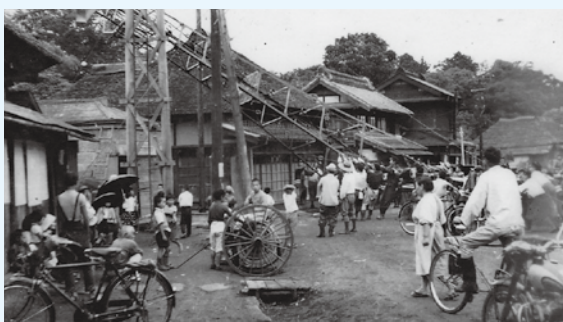
正源寺付近で火の見櫓を建てる様子(昭和20～30年代)
