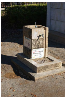
給水設備 (手洗い場・水飲み場)
