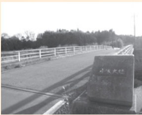
現在の小坂大橋
