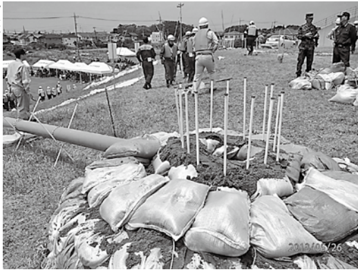
釜段工法 ：堤防が漏水した場合に、噴出口を中心に土のうを積みむことで水の噴出を止めます。
