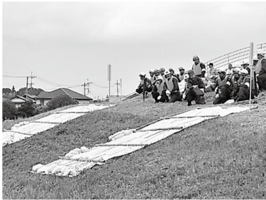
表席張り工法：水流により堤防の内側が崩れかけている箇所などをビニールシートなどで覆い、堤が崩壊するのを防ぎます。
