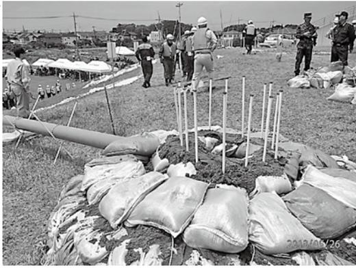
釜段工法：堤防が漏水した場合に、噴出口を中心に土のうを積みむことで水の噴出を止めます。
