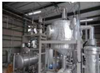
BDF 製造施設
